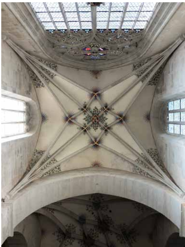
Gewölbe über dem Chorraum der Bebenhäuser Klosterkirche Foto: Stephan Gelhaus
