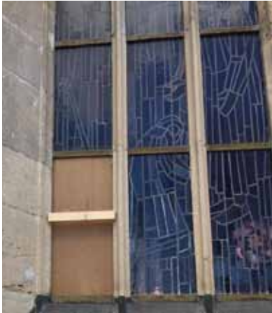
Zur Reparatur vorübergehend ausgebaut sind die beschädigten Fenster in der Kirche.
